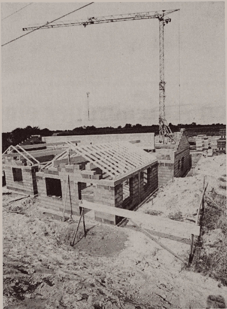
Einen zügigen Fortschritt nimmt der Bau des Nackenheimer Kindergartens. Das 1,3-Millionen-Projekt soll nach Aussagen der bauausführenden Firma bis Oktober fertiggestellt sein. Bild: Torsten Zimmermann
